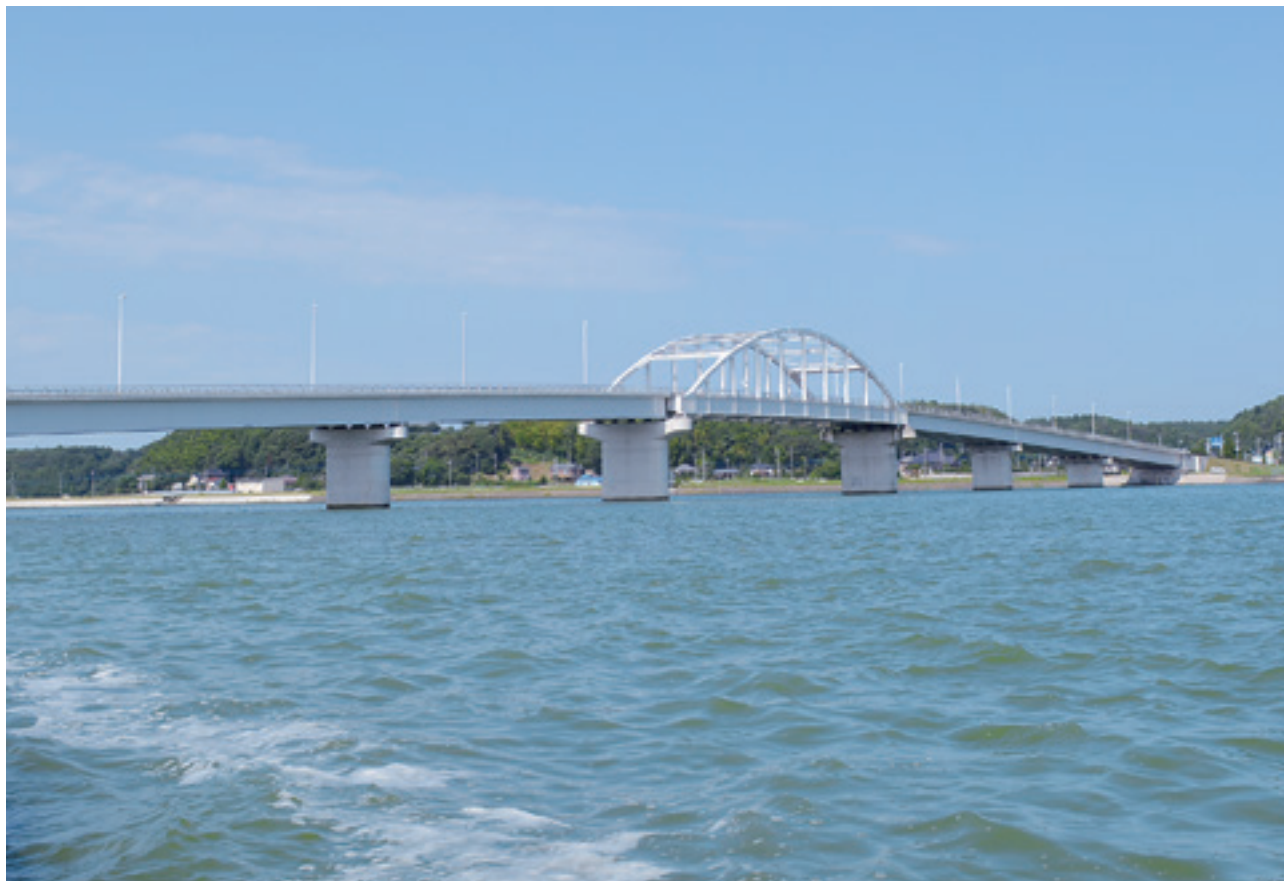
写真／震災から復興した鹿行大橋（行方市）
